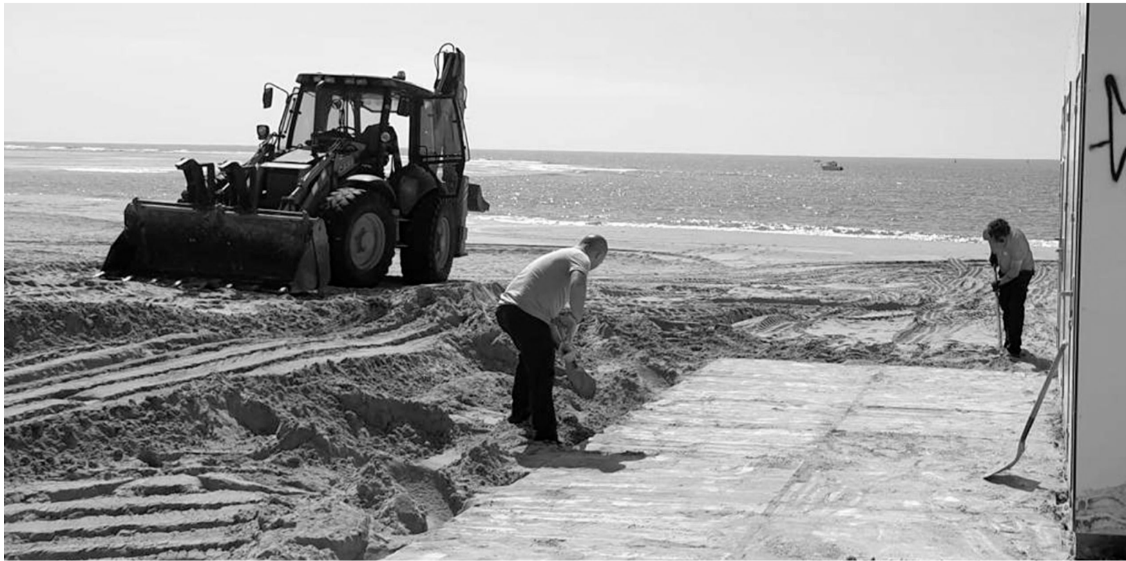
Operarios realizan trabajos de acondicionamiento en la playa.
