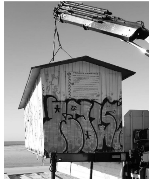
Retirada, por seguridad, del módulo.
